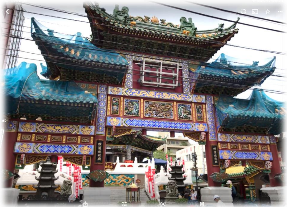
牌楼（改修工事前）
