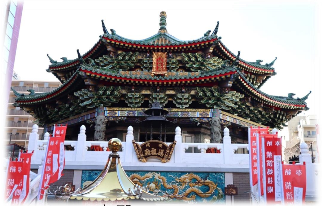
本殿（改修工事前）
